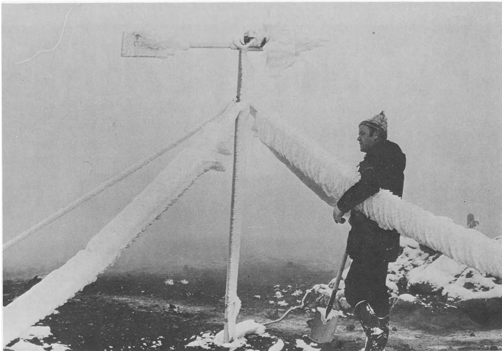
18. mynd. Einn mesti vandinn, sem glíma þarf við yfir vetrarmánuðina, er ísingin. Hér stendur Hjörtur Tryggvason við ísaða vindrafstöð á Leirhnúki. Ljós. H. Ólafsson
